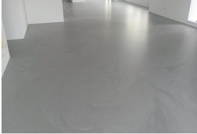
Grijze gietvloer dit is de vloer die door de hele winkel tot in de werkplaats ligt.
